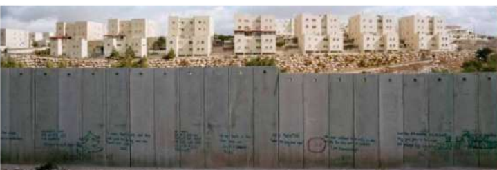
Mur entre Palestine et Israël depuis le camp de réfugié de Shuafat dans les environs de Jérusalem. 2009
